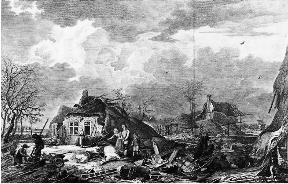
Verwoesting als gevolg van een dijkdoorbraak. (Bron: H. Ewijk, Geschiedkundig verslag der dijkbreuken enz. 1809. Foto: TU Delft).
